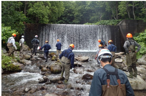
図5 カラフトマスの遡上を阻む治山ダム。調査で上流にも産卵に適した場所があることがわかった。
