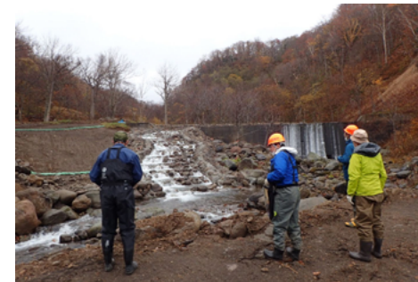
図8 フンベ川のダムに新設された恒久魚道。
