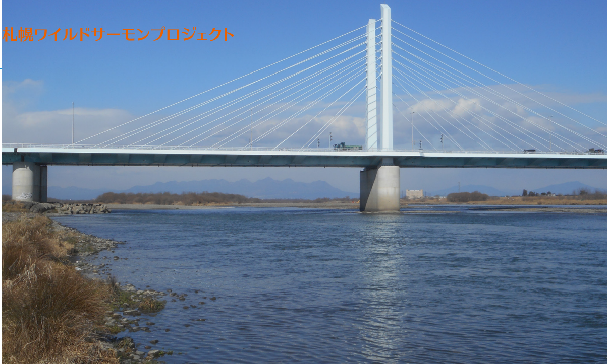
利根川・坂東大橋(八斗島)より上流を見る。
