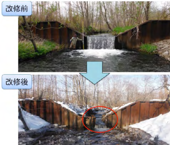
伊茶仁川支流ポー川の落差工の改修
